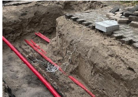
Installatie temperatuursensoriek
